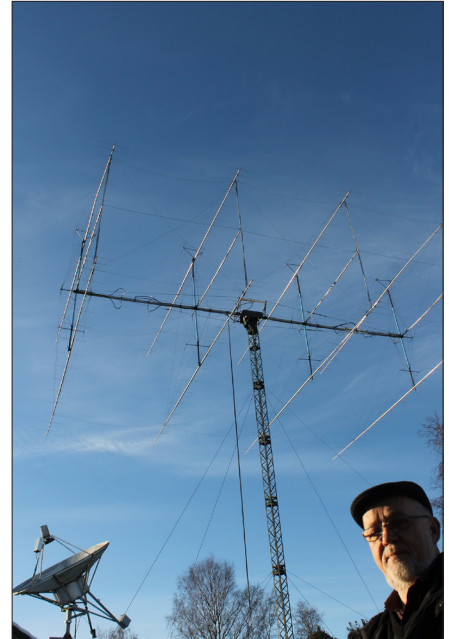
ES6RO praegune 8-st 144MHz ristyagist koosnev antennirühm.
