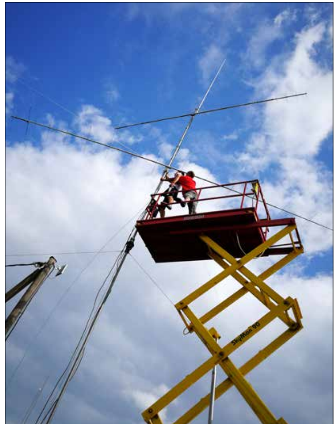
Pika 2m yagi paigaldamine tõstukilt
