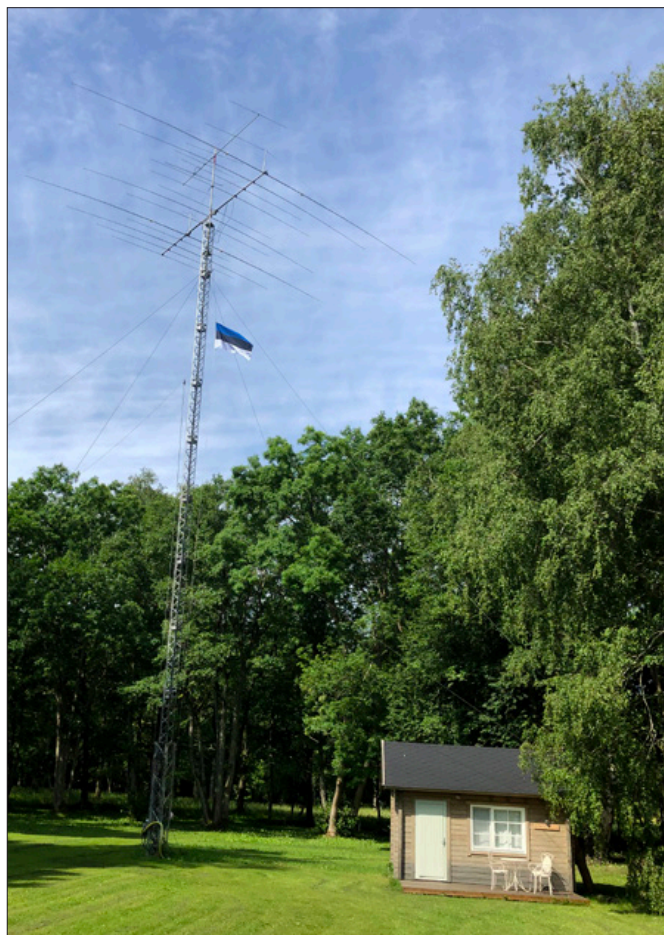
Igor, ES0IA on oma suvekodus Hiiumaal Kassaris saanud püsti korraliku masti, mille otsas on 4-bändi UA2FZ-i yagi (2 el 40m, 3 el 20 ja 15m, 4 el 10m), lisaks 6m antenn ja mitmeid traatantenne. Tulemusedki ei lasknud end oodata! :)
