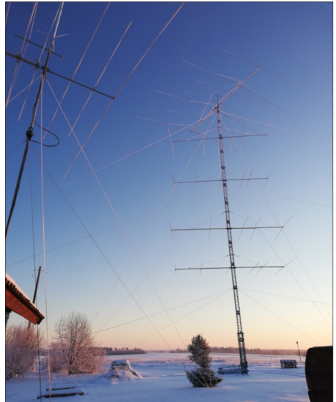
Kaua tehtud, kaunike – üleval pööratav 40/20m dualbander, all 2x5 el 15m ja 2x6 el 10m.
