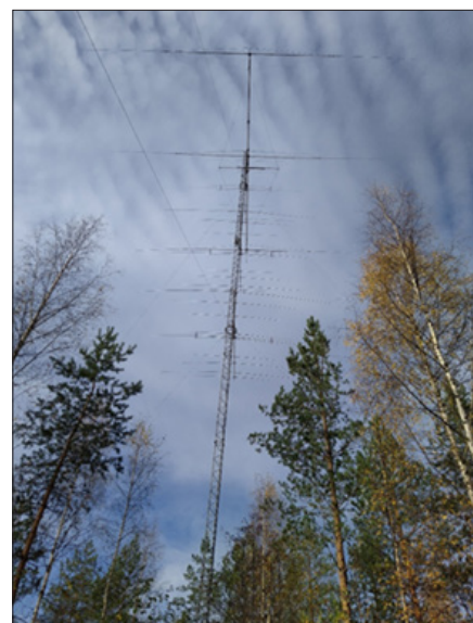
Mast tribänderite ja 80m yagiga.
